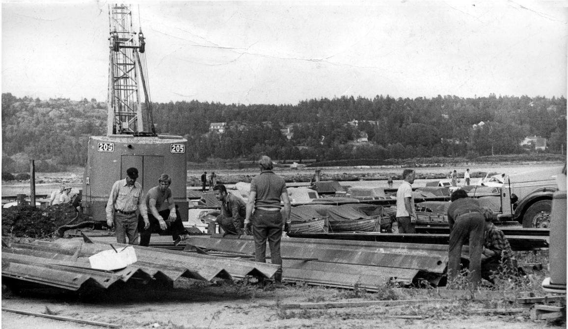
Det ble slått ned stålsputtvegg i 1975 i 90 meters lengde.
