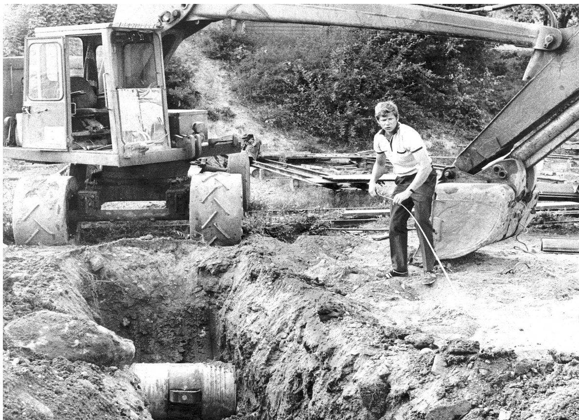
Odd Wang er en av de mange ildsjeler som har lagt ned utallige dugnadstimer slik at havna kan fremstå som den gjør i dag. Her under sikring av den nye spuntvekken i 1975
